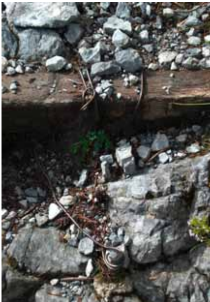
Mit Wasserrohren gesicherter Steig zur Nürnberger Hütte - Stubaital. Fotoarchiv Andreas Rauchegger
