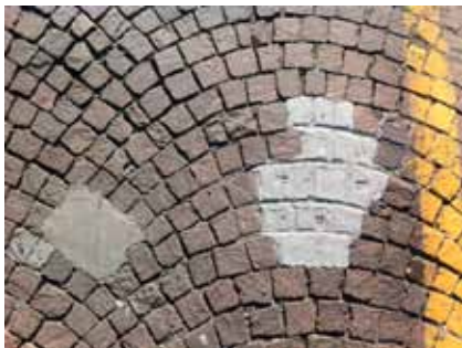
Gsies, Durchwald Weberhof: Reparaturen und Flicke an der Südfassade. Fotoarchiv Pescoller Werkstätten
